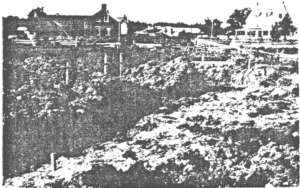
(18) Looking N. Corner D in background
